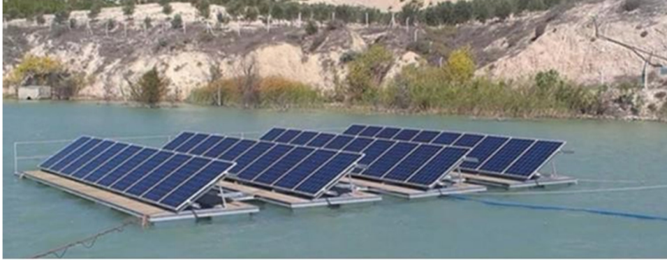
Şekil 13. Azmak HES Yüzer Güneş Enerjisi [18]
