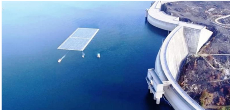
ŞEKİL 22. Hidro, Yüzer PV Hibrit Sistem [32]
